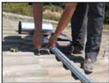
Fijación de las pletinas
