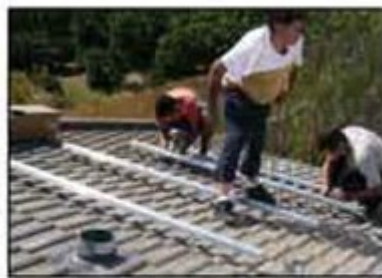
Colocación de los perfiles de soporte
