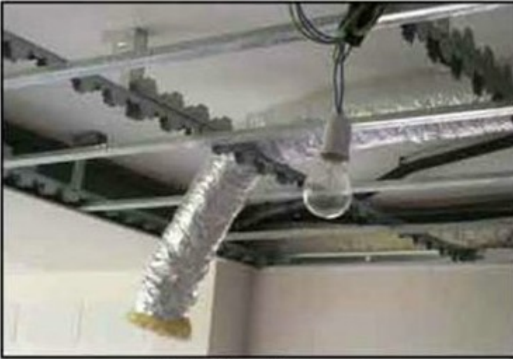
Cielo Falso sala de estar
